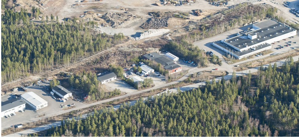
Suunnittelualueen rakennuskantaa ja 110 kV voimalinja (2023)
