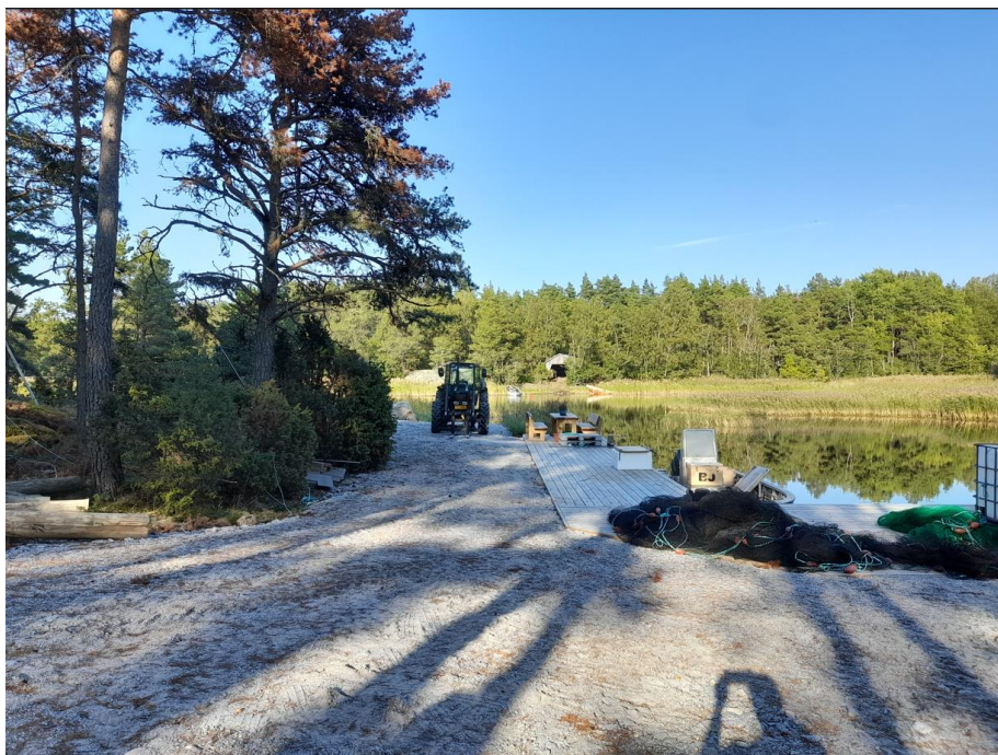
7. AL-alueen itäosaan rakennettu laituri
