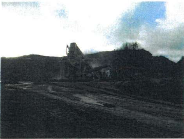
Kuva 9. Murskauslaitos paikassa 2 (ylätaso).
