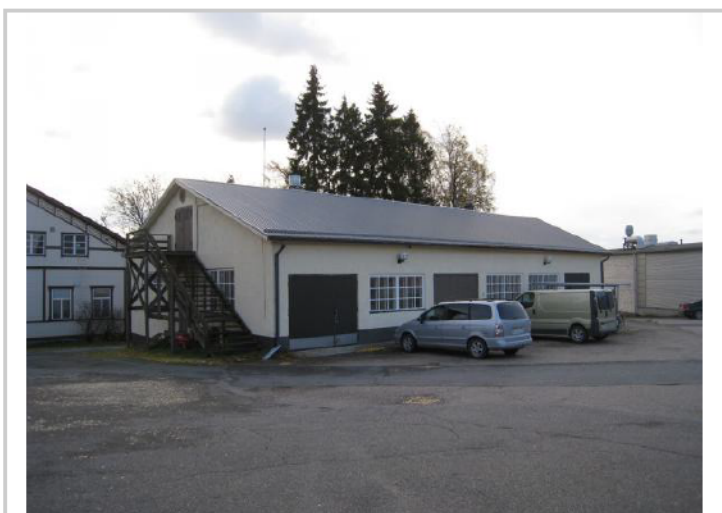
Luoteissivu ja koillispääty
